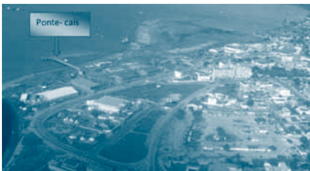
Figura 4 Porto de Cabinda (Fonte: Cabinda, 2007).
