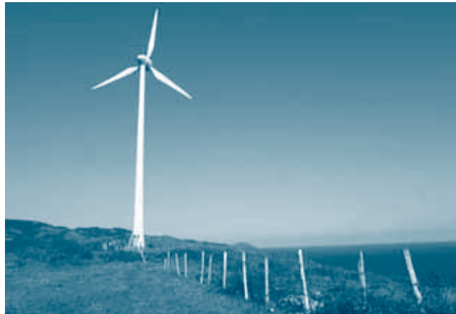
Imagen del parque eólico do Figueiral (Santa María)
